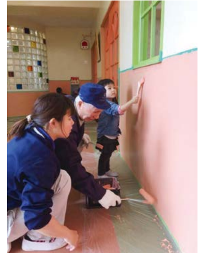
安全な水性塗料なら幼稚園で昼間の作業も
