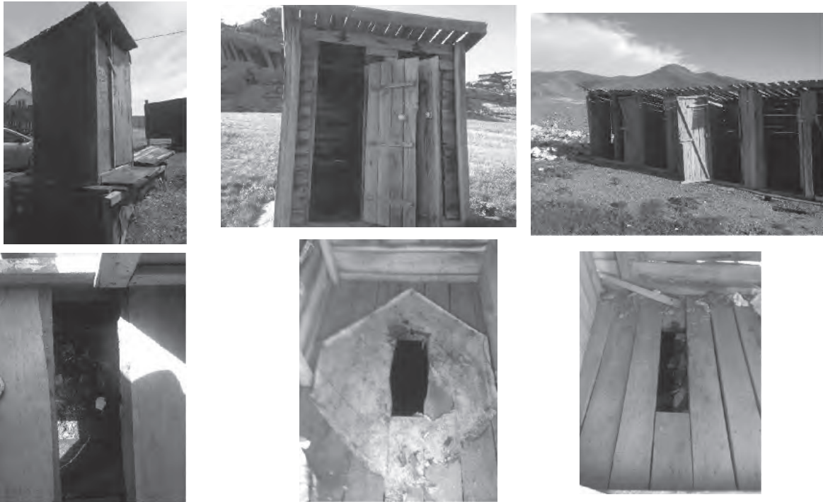
基本的には素掘りの土壌還元方式のトイレ
